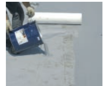
2. KEMPEROL® wird auf den Untergrund aufgebracht
