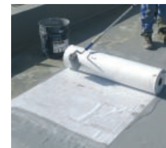
3. Das KEMPEROL® Vlies wird eingelegt und mit einem Perlonroller angedrückt
