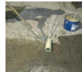
1. Untergrundvorbereitung nach Grundierungsempfehlung
