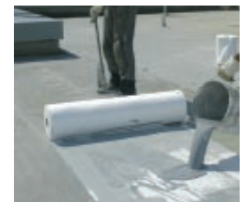
4. KEMPEROL® wird nachgelegt und das Vlies vollständig durchtränkt
